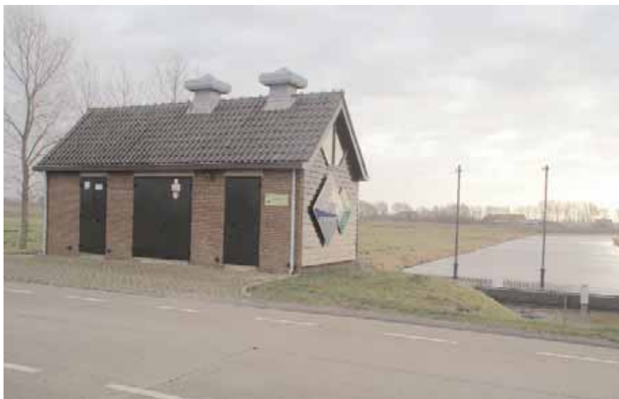
Het gemaal Noordermeer aan de oostzijde van het kanaal door Voorne, vernoemd naar Arie Lambrecht Noordermeer, voorzitter van het polderbestuur van de polder Oudenhoorn van 1943 tot 1966 (foto F. Keller).
