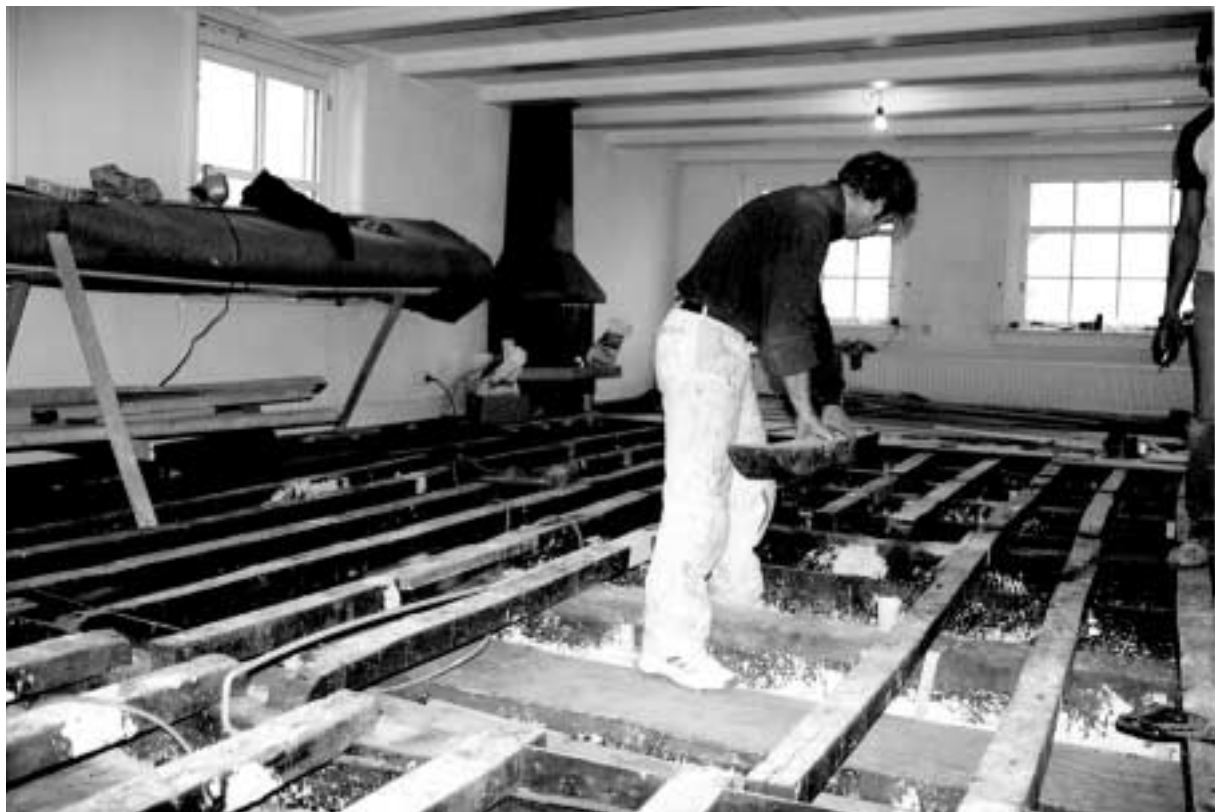
Het plafond werd van de bovenzijde gerestaureerd. Hiertoe moest de bovengelegen vloer worden weggebroken.
