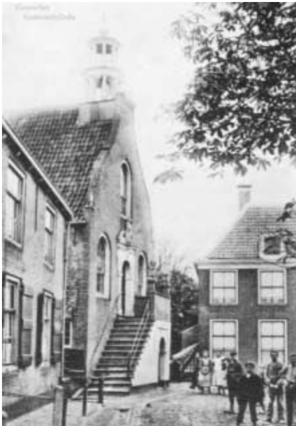
Het voormalige stadhuis van Geervliet; rechts het woonhuis van J.D. Preuijt
