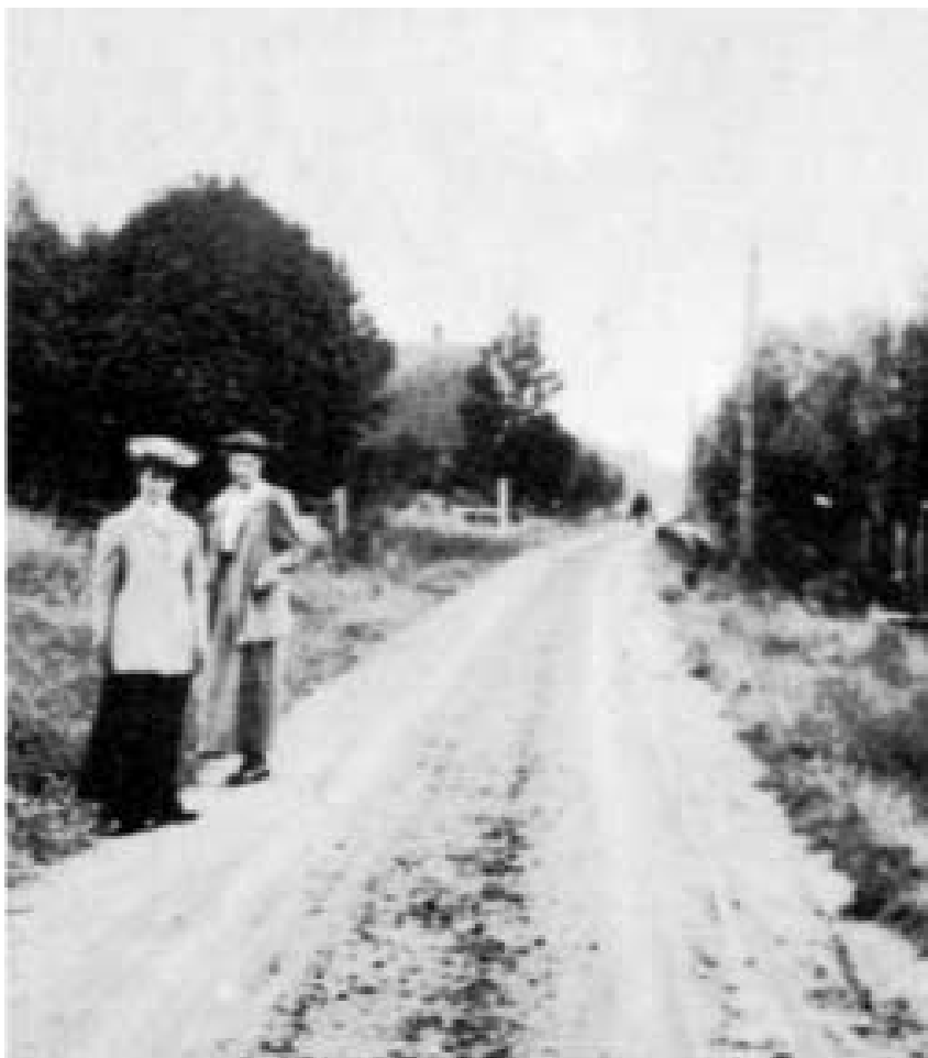
Afb. 7: op deze foto van de Waterweg van omstreeks 1910 is op de achtergrond ( links van de weg ) de Zwartewaalse vrijpaal zichtbaar.
