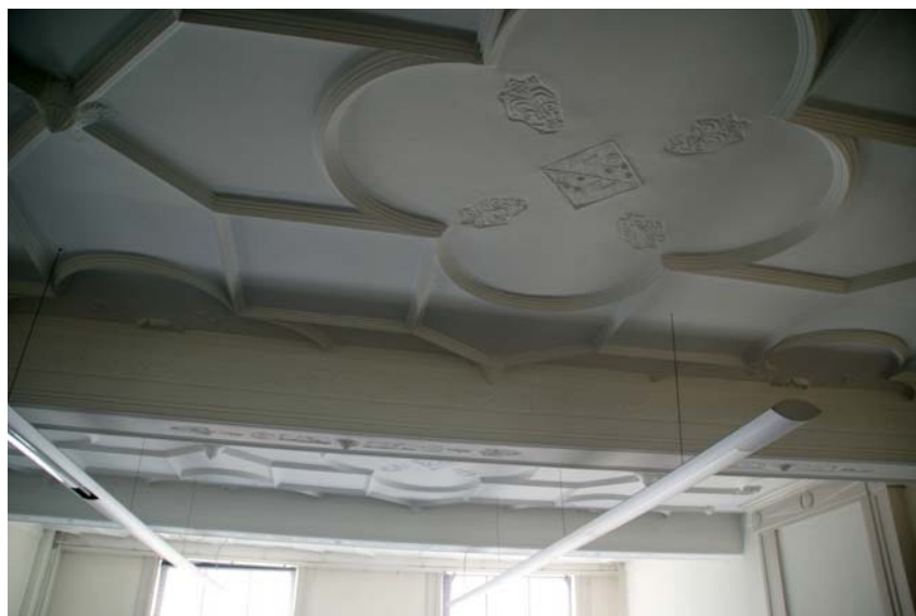
Afb. 22: stucplafond in de voorkamer op de eerste verdieping van het linker huis. Foto F. Keller.
