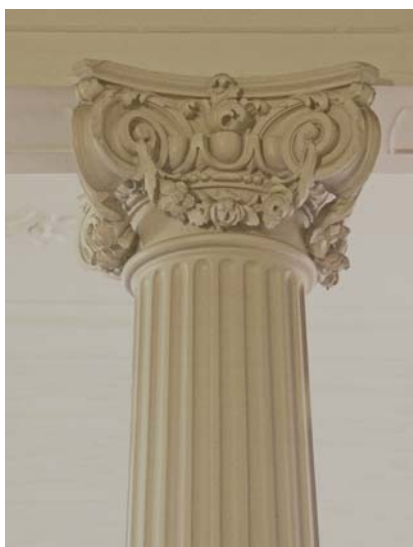
Afb. 8: kolom in de hal op de begane grond. Foto F. Keller.
