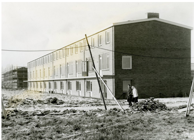
Woningen in aanbouw aan de De Kanterstraat.
