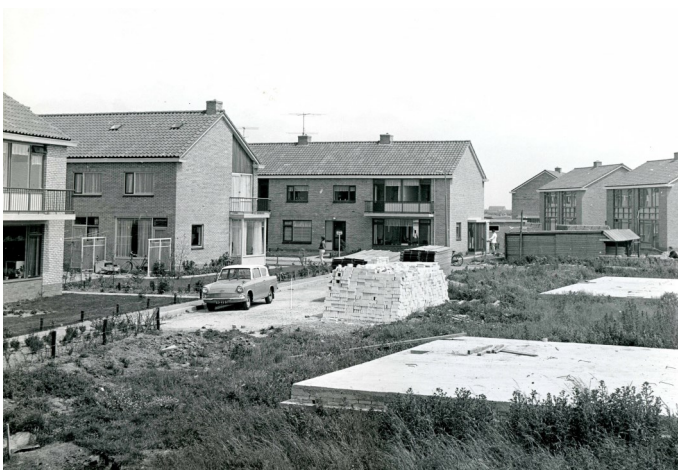
Woningen in aanbouw aan de Lumeyweg. Foto Streekarchief Voorne-Putten
