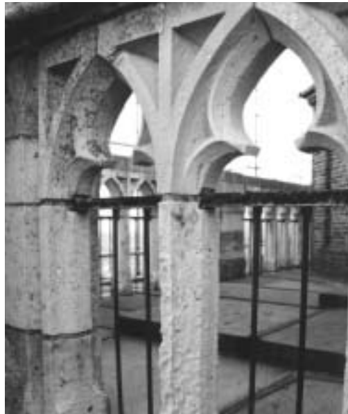
Reparatie van de balustrade: duidelijk is de verbetering te zien: onder oud, boven nieuw.
