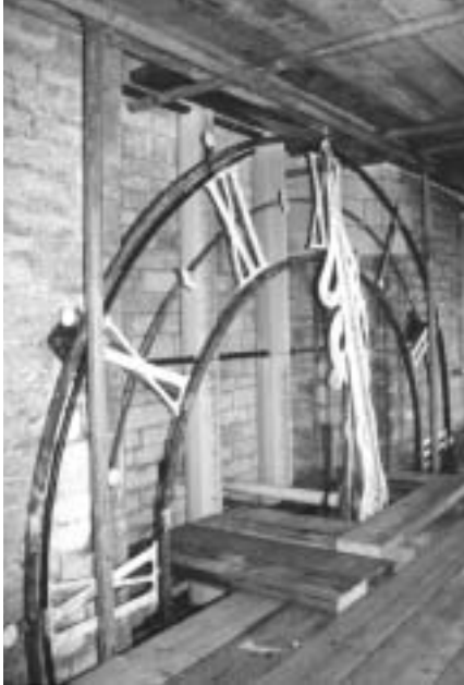
Reparatie van de wijzers en van de wijzerplaat
